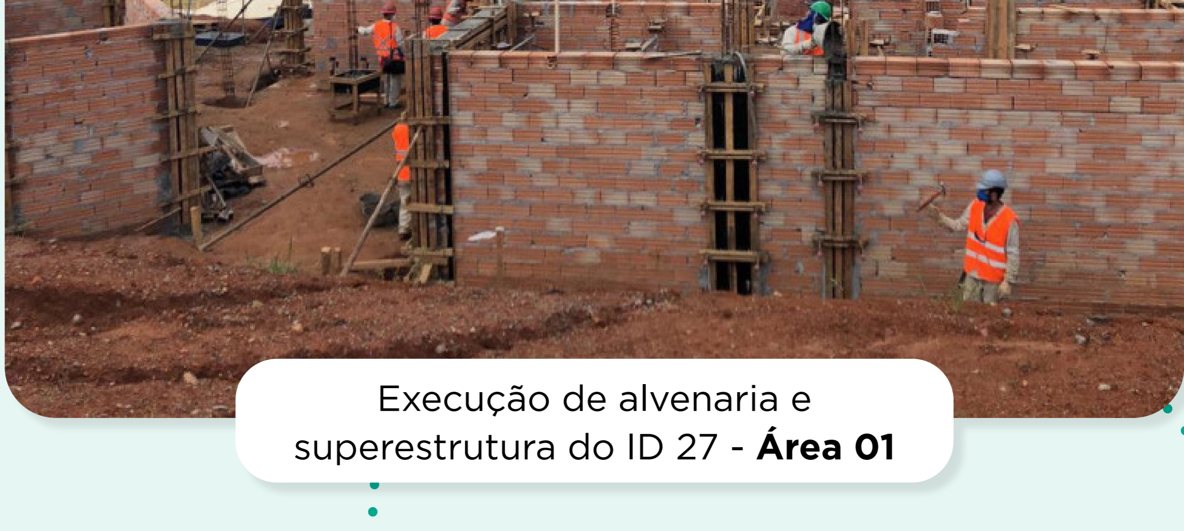
Execução de alvenaria e superestrutura do ID 27 - Área 01
