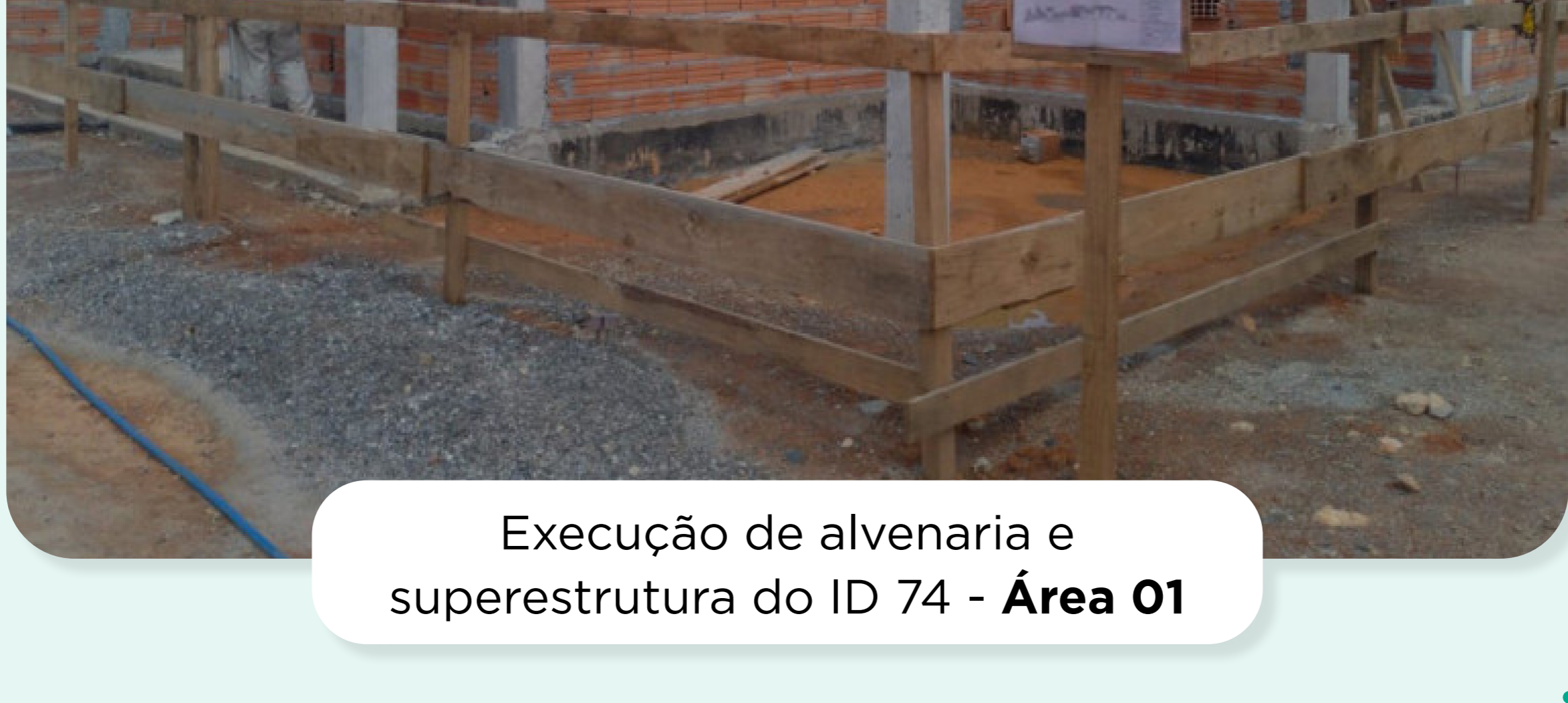
Execução de alvenaria e superestrutura do ID 74 - Área 01
