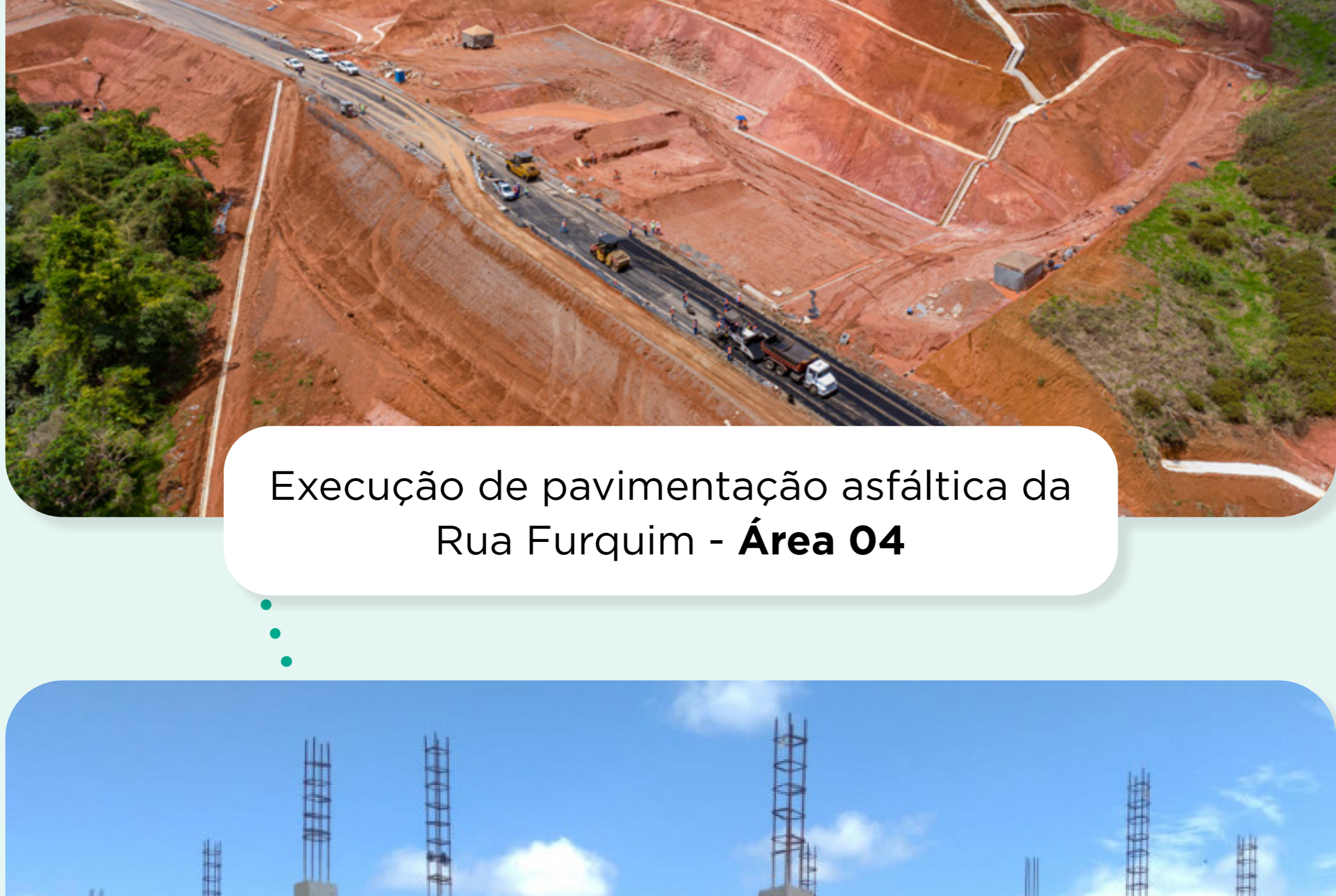
Execução de pavimentação asfáltica da Rua Furquim - Área 04
