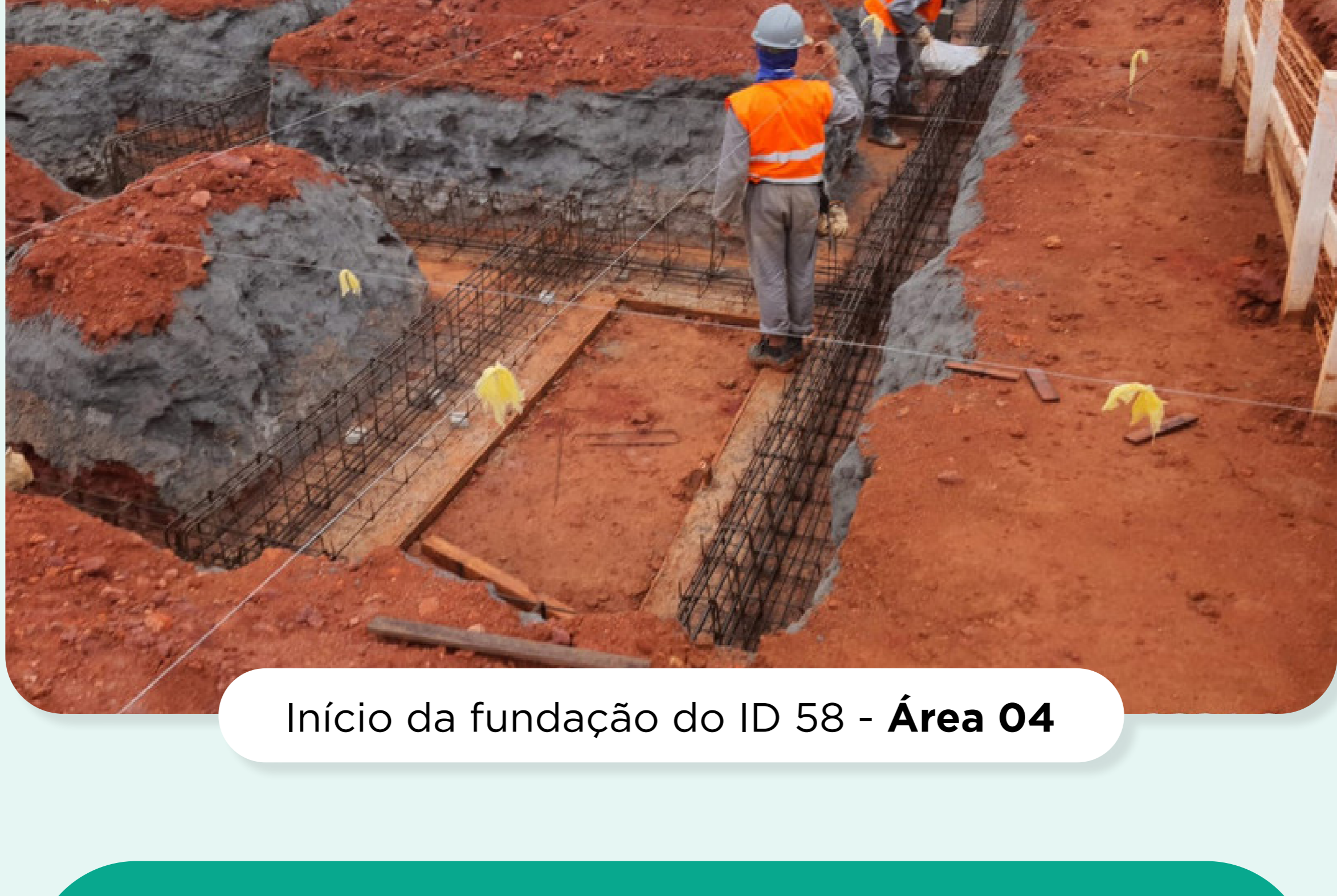
Início da fundação do ID 58 - Área 04
