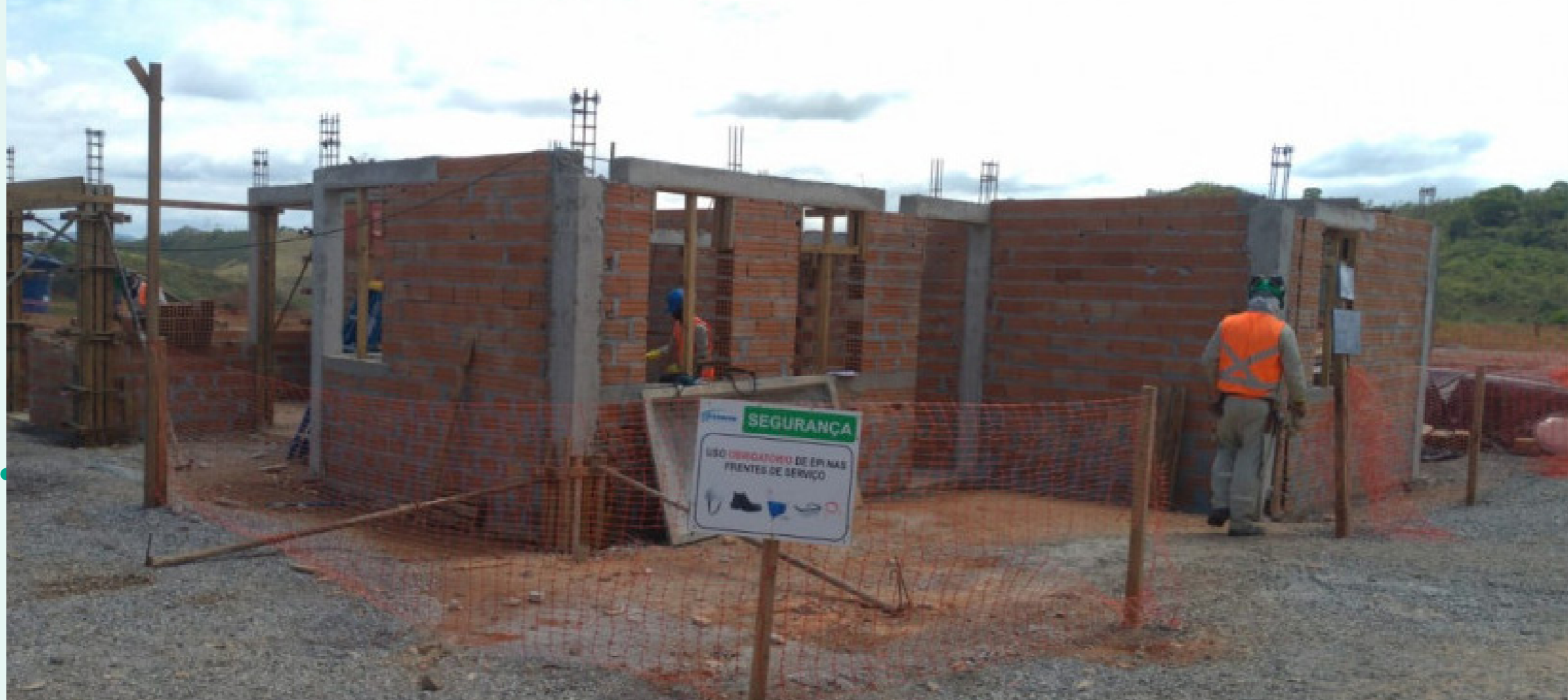
Execução de alvenaria e superestrutura do ID 84 - Área 01
