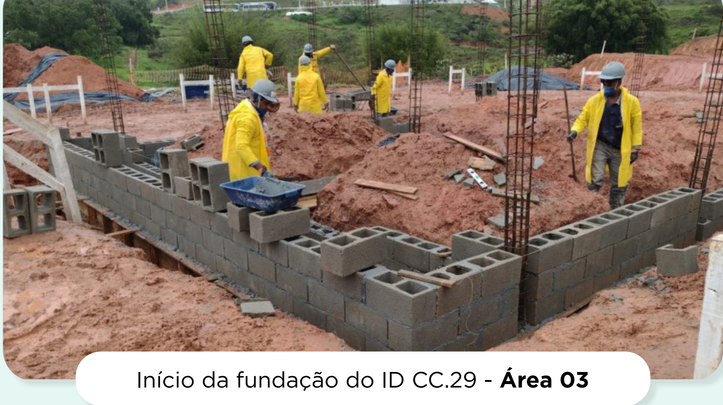
Início da fundação do ID CC.29 - Área 03
