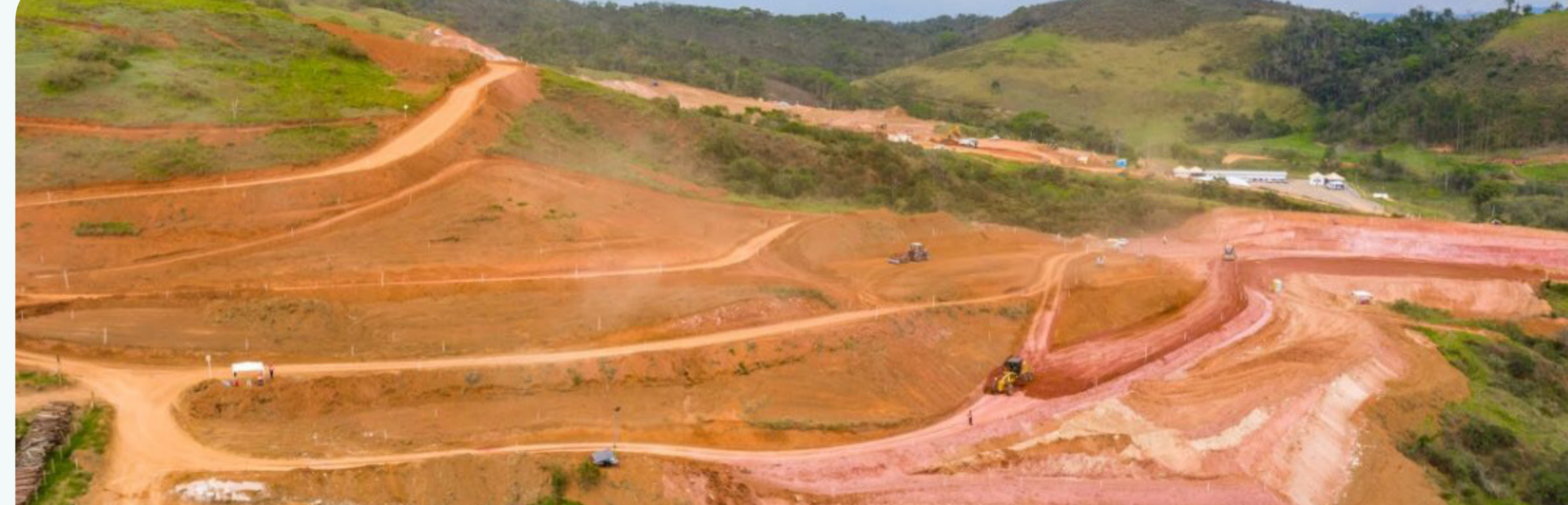
Terraplenagem do acesso principal
