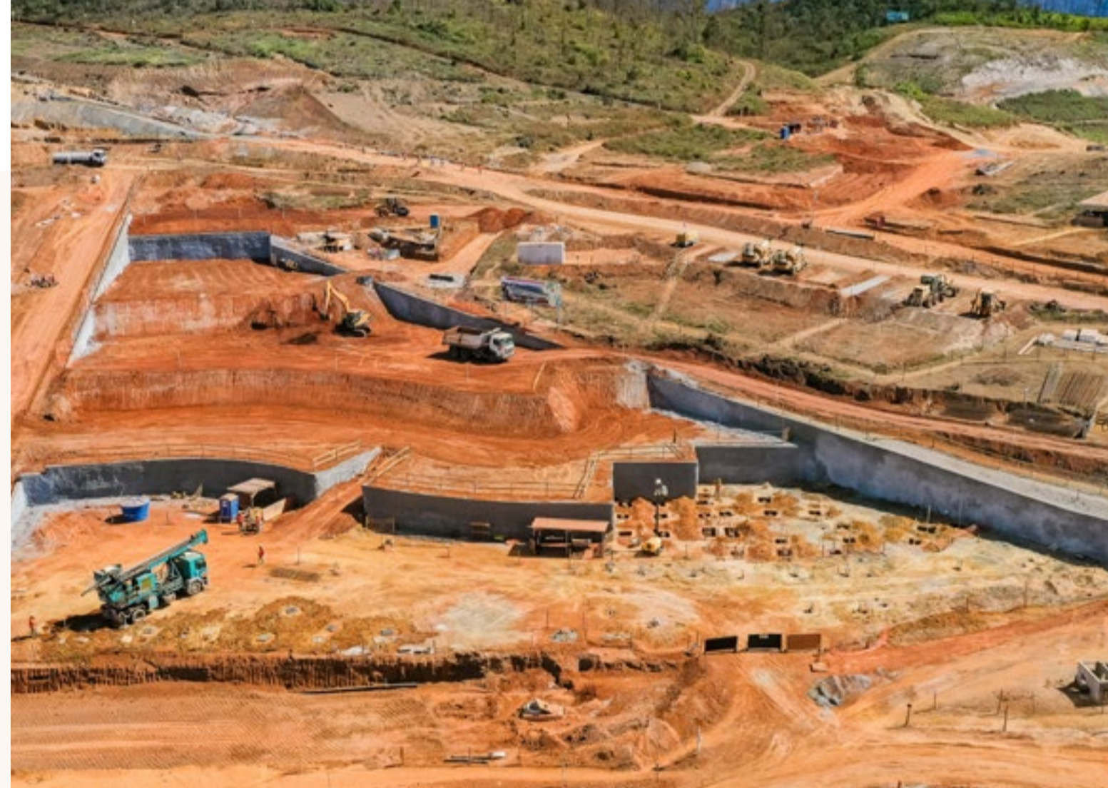
Contenções da escola municipal concluídas
