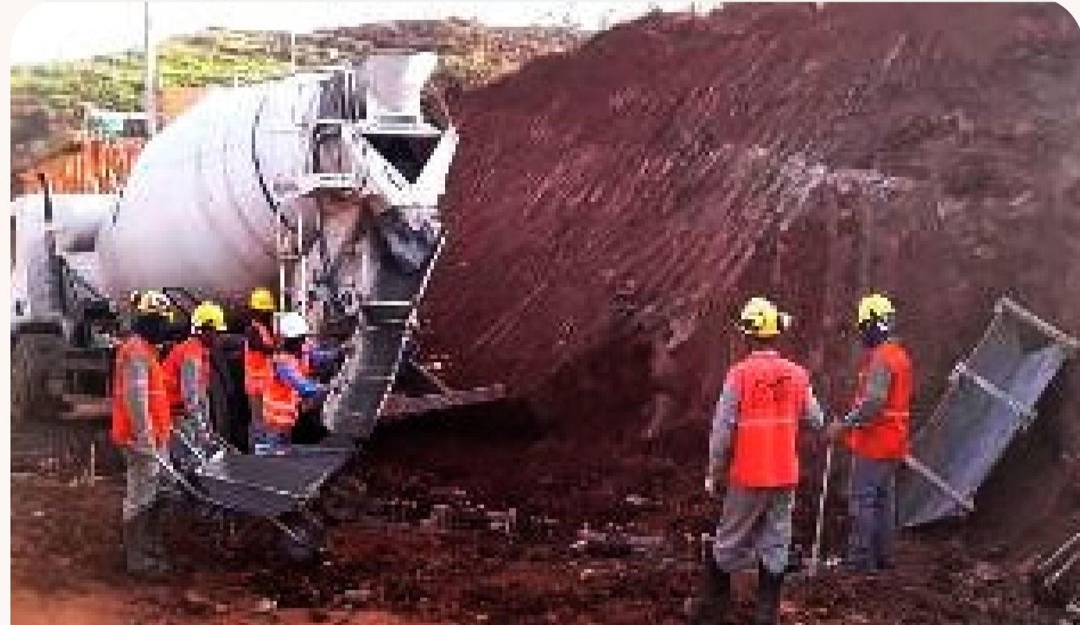
Concretagem de estacas de contenção do posto de saúde concluída
