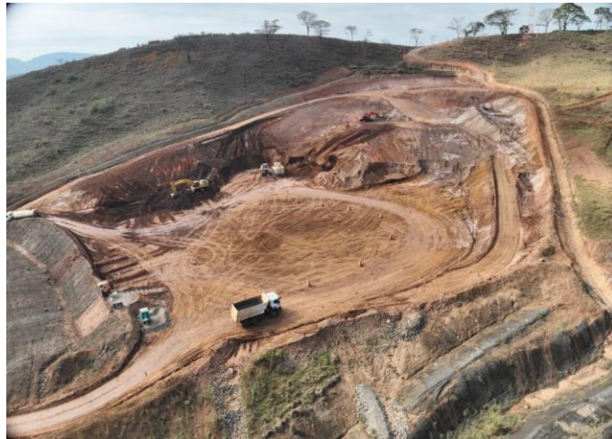
Figura 2 - Em andamento descaracterização das estruturas ADME-2
