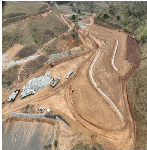
Figura 4 - Contrapilhamento O.E Dique Principal
