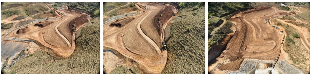
Figura 5 - Contrapilhamento O.E Dique Principal
