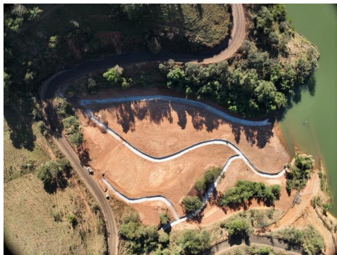
Figura 3 – Descomissionamento e implantação do sistema de drenagem Setor 5b
