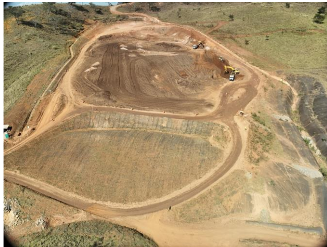
Figura 2 - Em andamento descaracterização das estruturas ADME-2
