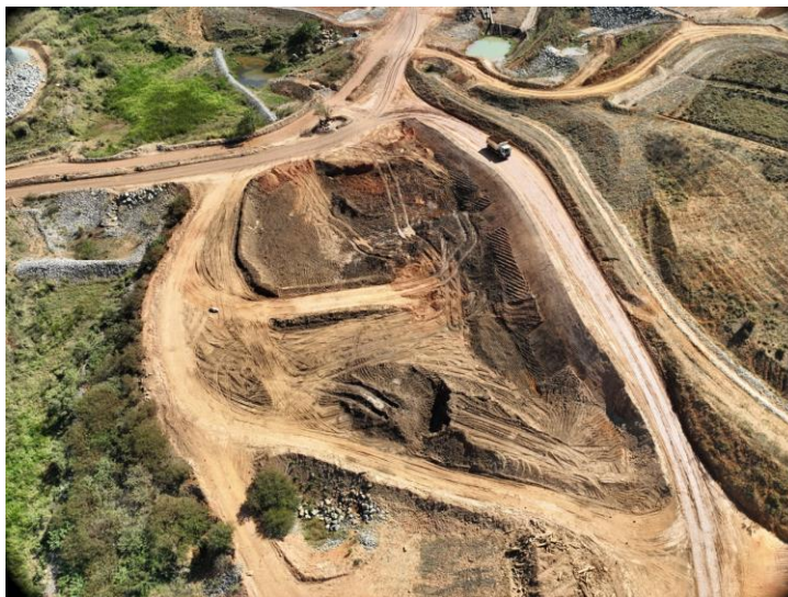
Figura 1 – Em andamento descaracterização das estruturas AAS4
