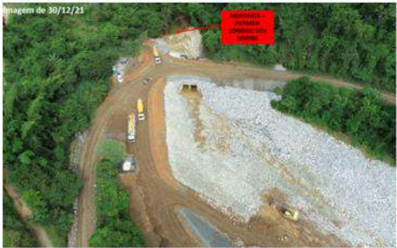
Figura 17 – Montante Barramento Setor 4 – Entrada
