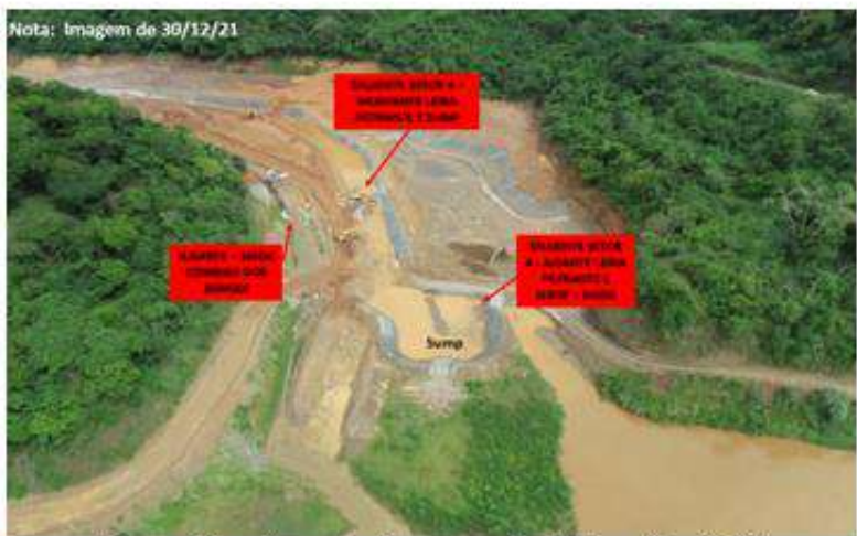
Figura 18 – Jusante Barramento Setor 4 – Saída
