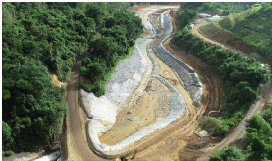
Figura 2 - Vista a montante do Dique Setor 4
