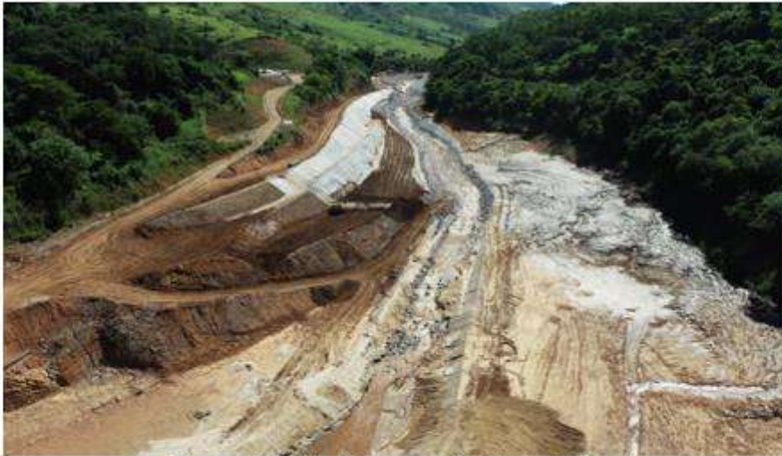
Figura 1- Vista à jusante do Dique Setor 4
