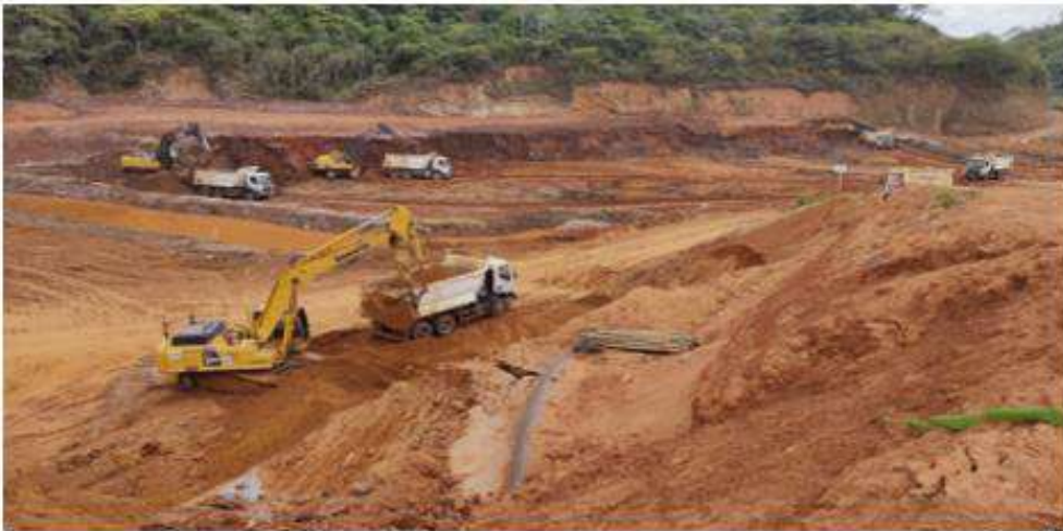
Figura 1- Vista à jusante do Dique Setor 4
