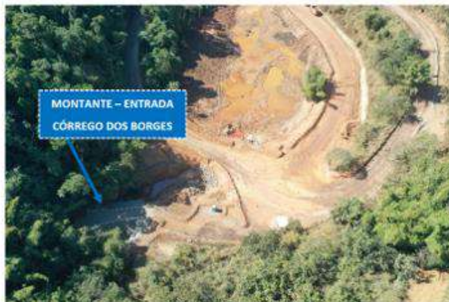
Figura 24 - Montante Córrego dos Borges
