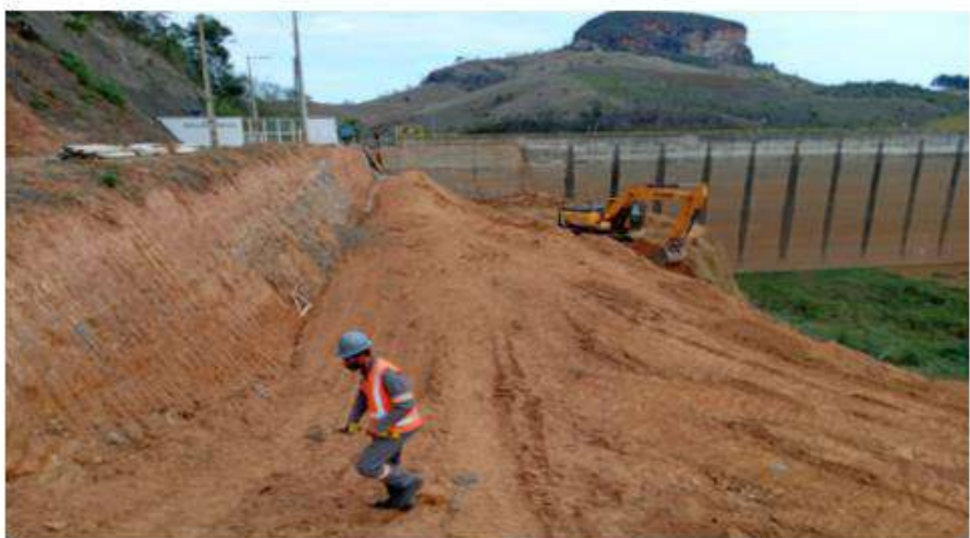
Figura 9 - Remoção de terramesh
