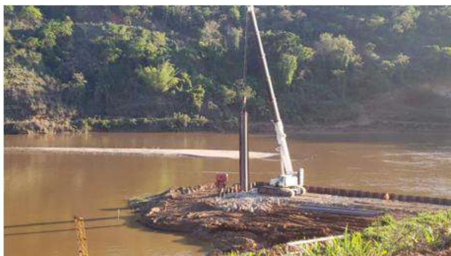
Figura 7 - Execução de cravação de estacas
