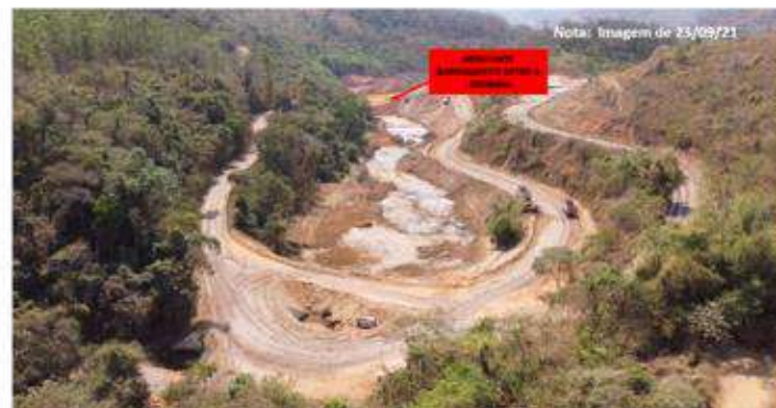
Figura 21 - Montante Barramento Setor 4 - Entrada
