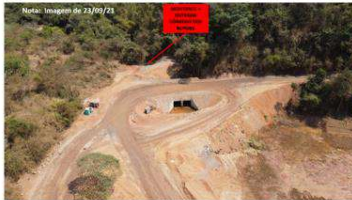
Figura 20 - Montante Córrego dos Borges
