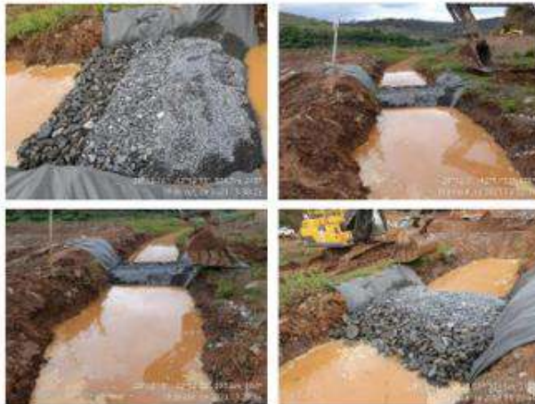
Figura 23 - Melhorias Descomissionamento Setor 4
