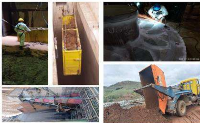
Figura 13 - Limpeza Entre a Comporta e a Descida do Conduto e recuperação do braço do vertedouro VT1
