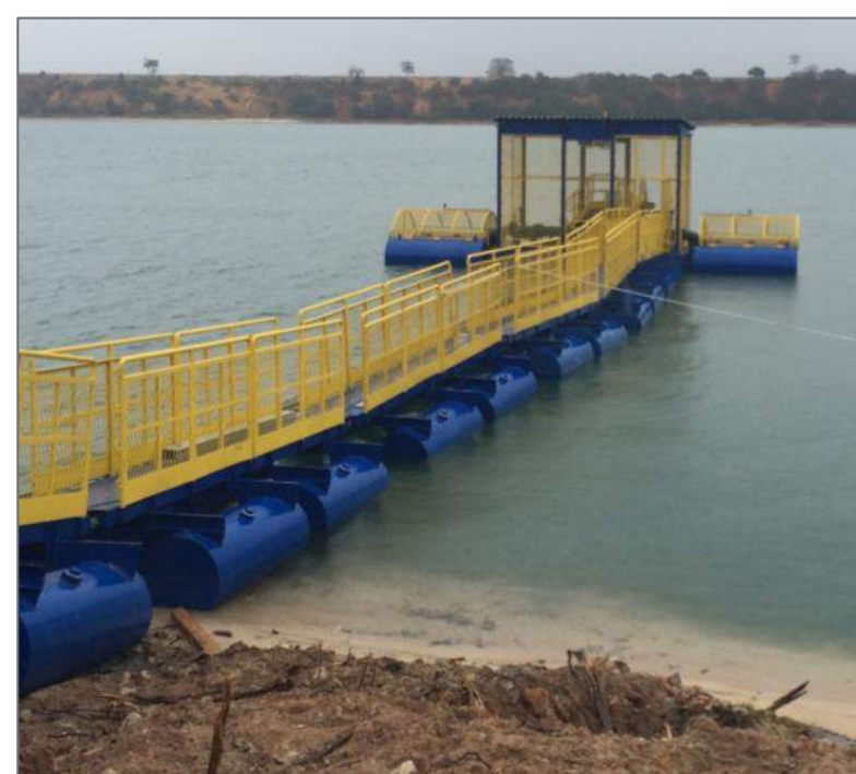
Andamento das obras da adutora de Linhares - Conclusão da obra da Adutora - Comissionamento (Operação assistida)
