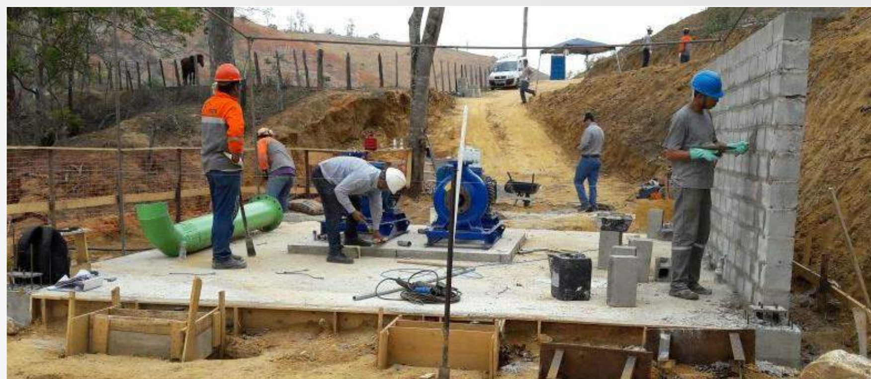
Andamento das obras Santa Maria (Colatina): - Início da base civil e estrutura civil estação de bombeamento
