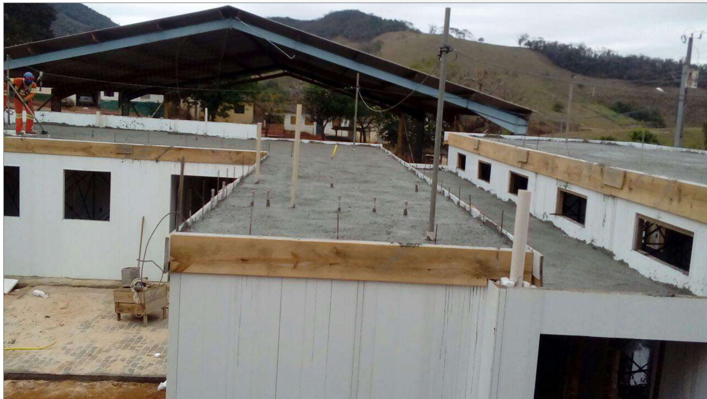
Concretagem da laje da Escola
