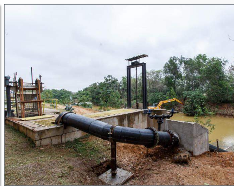
Andamento das obras da adutora de Linhares - Conclusão da obra da Adutora - Comissionamento (Operação assistida)
